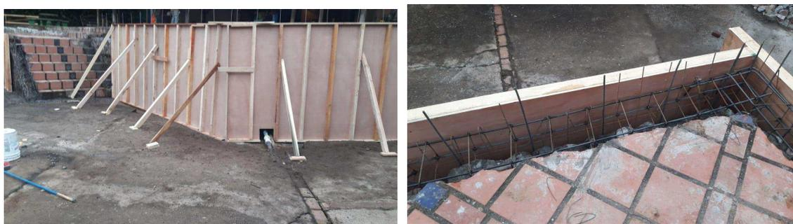
28            Fotografías # 12 y # 13. Colocación de encofrado para colado de pantalla de concreto.
