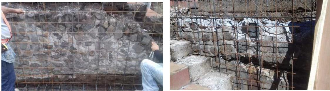
9            Fotografías # 8 y # 9. Reforzamiento del paramento con malla y nueva placa de fundación.
