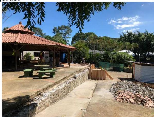
Fotografía # 5. Eliminación de baranda y corte de parte superior de muro, para colocación de viga corona de refuerzo.
