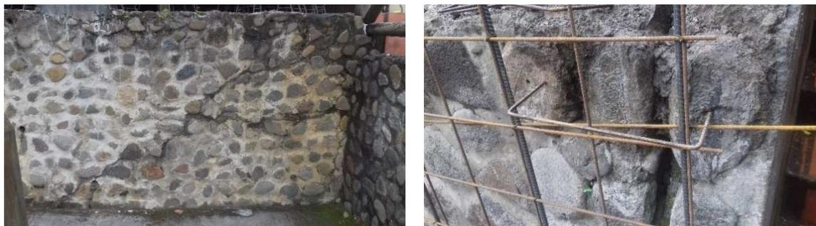
1            Fotografías # 6 y # 7. Estado de agrietamiento original de muros y proceso de "cosido" de
