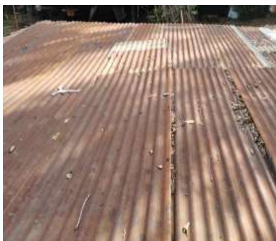
Fig # 6: Condiciones de deterioro por oxidación de la cubierta de techo
