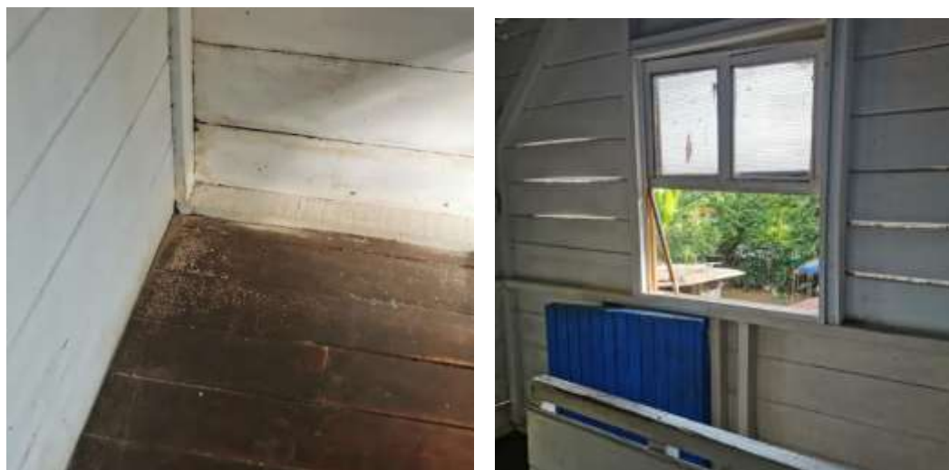
Fig # 4: Condiciones de deterioro de los pisos e irregularidades de nivel en estos.
