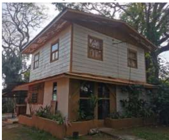
Fig # 1: Vista general de la casa.
