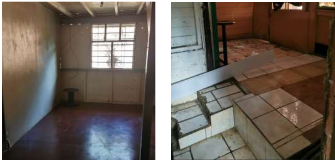
Fig # 4: Condiciones de deterioro de los pisos e irregularidades de nivel en estos.
