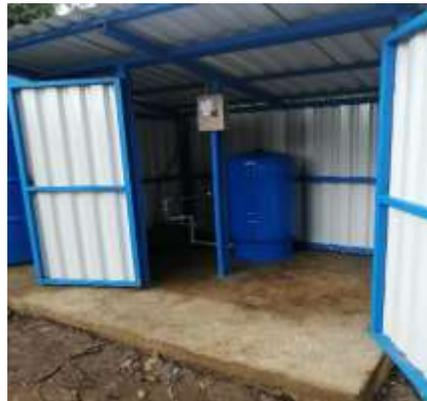
Fig # 7. Tanque hidroneumático y bomba.
