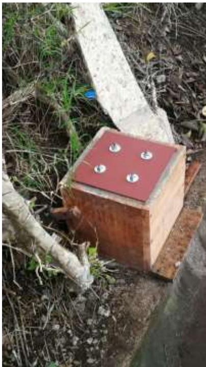
Fig # 9. Pedestales para apoyo de paso techado con el encofrado colocado.
