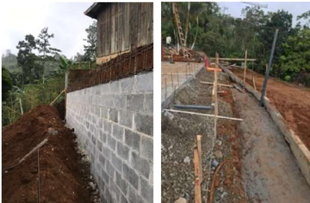
Fig # 2. Conformación de muros de retención.
