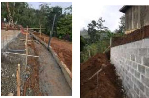
Fig # 2. Conformación de muros de retención.
