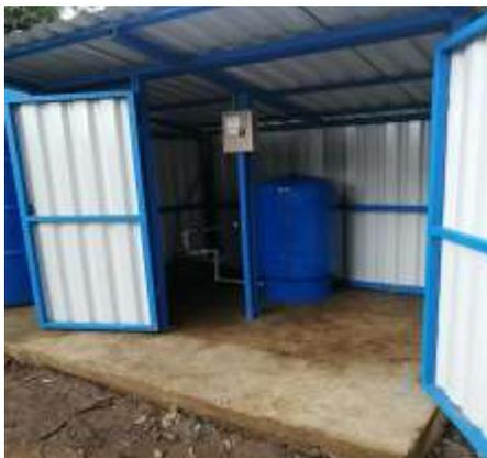
Fig # 7. Tanque hidroneumático y bomba.
