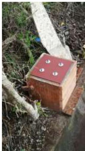
Fig # 9. Pedestales para apoyo de paso techado con el encofrado colocado.
