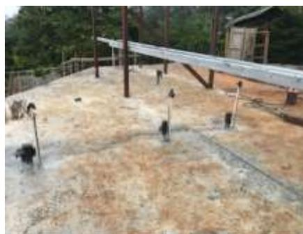
Fig # 3. Losa de fundación para servicios sanitarios y vestidores.
