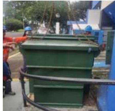
20 Izado y colocación de transformador nuevo.-----
