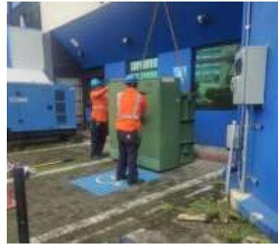
11 Desinstalación del transformador dañado. -----
